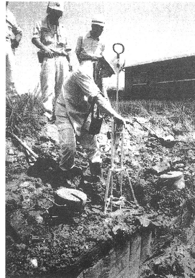
写真一2 No.2測点
